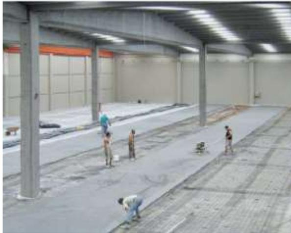
*Imagen 2.4.3.5.1. Ejemplo de extendido del pavimento<sup>36</sup>*
