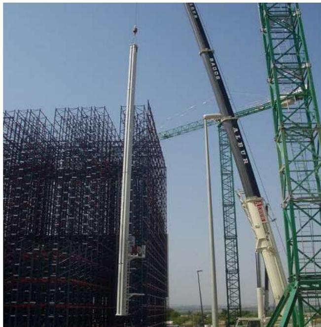
*Imagen 2.4.4.1. Ejemplo de instalación de un transelevador junto a estanterías<sup>37</sup>*
