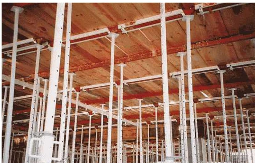
*Figura encofrado tradicional de losas*
