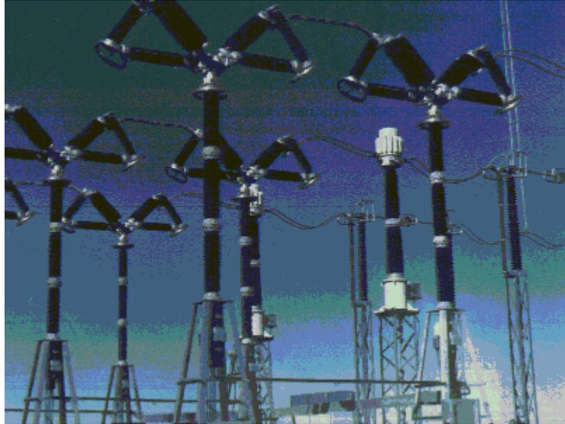
Fig. 2.5 vista interruptores de alta tensión
