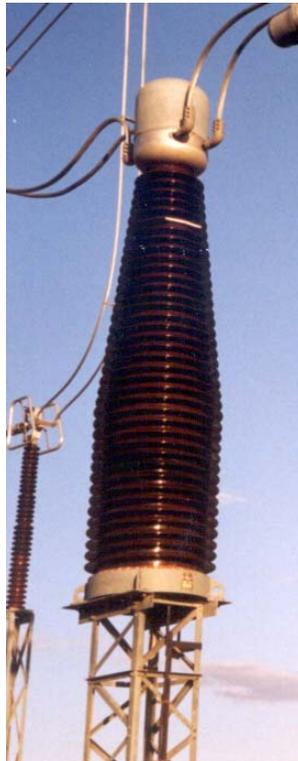
Fig. 2.4 Vista de un transformador de corriente
